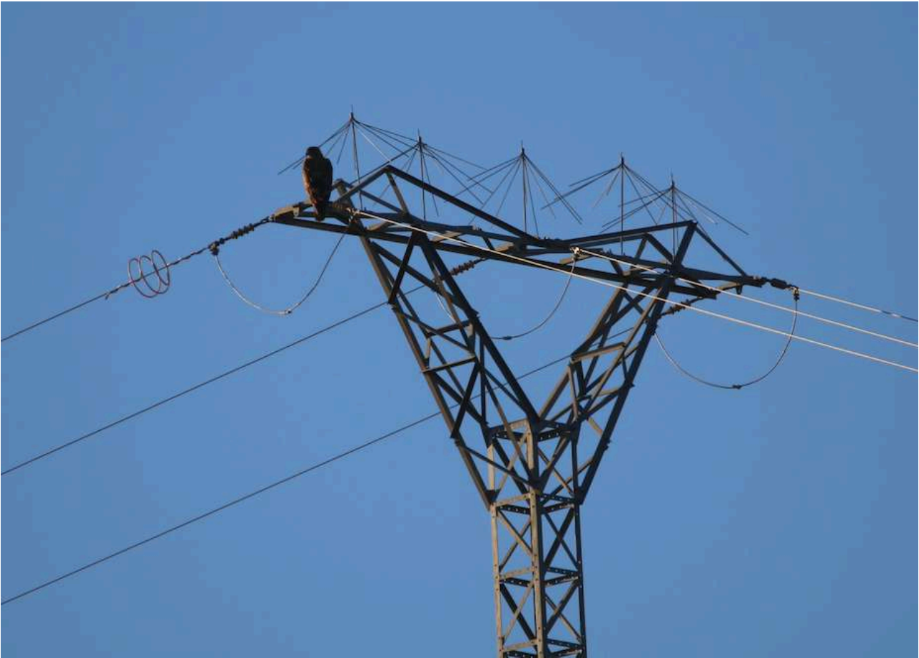
Fotografía 3: águila imperial ibérica posada en una torreta eléctrica con elementos disuasorios de posada, eso le obliga a posarse más cerca de los conductores. Photograph 3: Spanish Imperial Eagle perched on an electrical transmission turret with perch deterrents, forcing it to perch closer to electrical conductors. R. Sanchez 2022 ©
