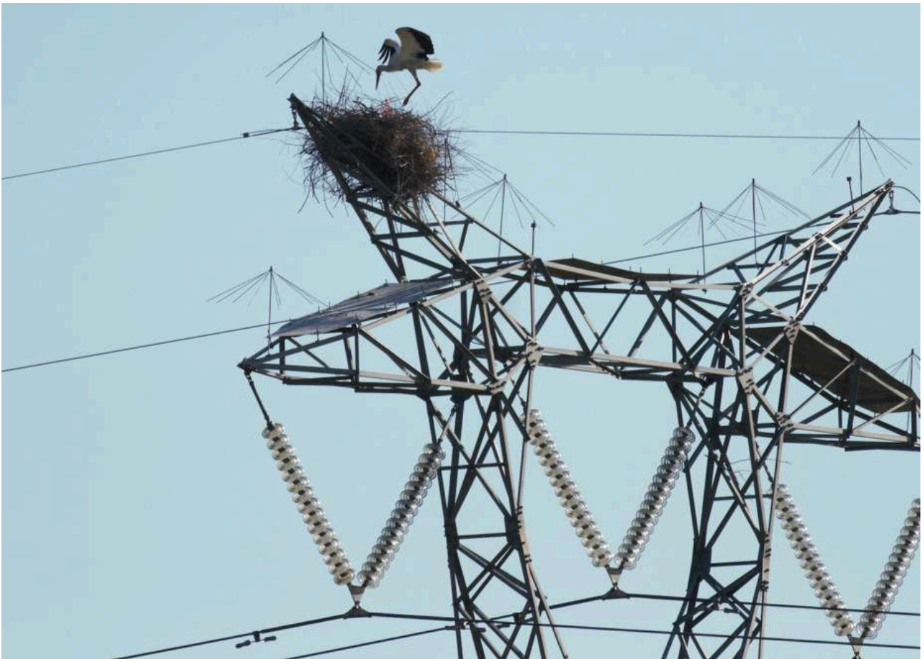
Fotografía 4: Nido de cigüeña blanca en una torreta eléctrica con dispositivos disuasorios de posada y de nidos. Photograph 4: White stork nest in an electrical transmission turret with perching and nest deterrent devices. (Macaulay Library ML279401721, eBird checklist S76151433 © Frédéric Bacuez.
